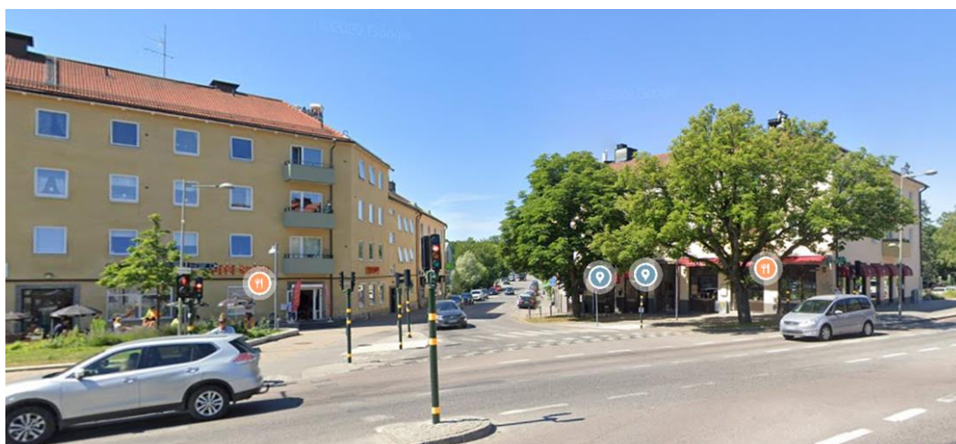
Korsningen Älvsjövägen/Johan Skyttes Väg mot söder och planområdet. Flerbostadshus med lokaler i entréväning. Korsningen är markerad med indragen bebyggelse och trädplanterade torg.
