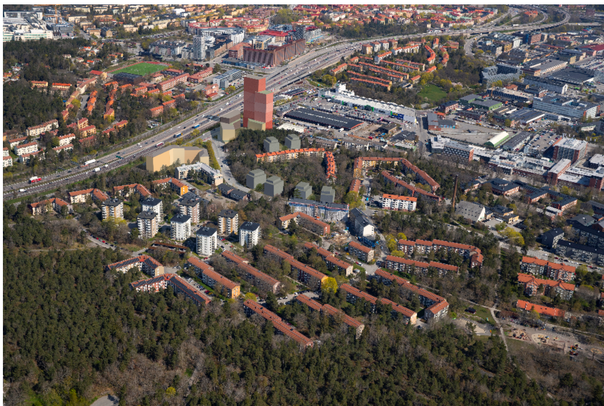
Fotomontage på flygbild med studerade byggnadsvolymer sett sydost ifrån, med Solbergaskogen i förgrunden. Foto Lennart Johansson. Illustration ÅWL, Joliark och Urban Design.
