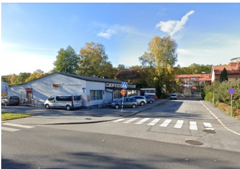
Befintlig byggnad på Kopplingsboxen 26.
