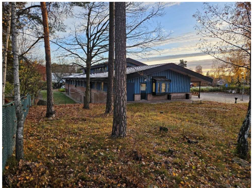
Vy av fastigheten från väst, foto taget från Annebodavägen. Två av de tre skyddsvärda tallarna syns i förgrunden.
