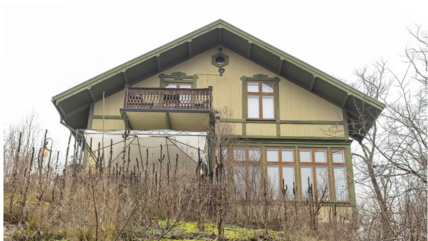
Bild 9. Östra flygelns fasad mot väster med ursprunglig balkong mot Långsjön. Balkongräcken i utsirat trä.
