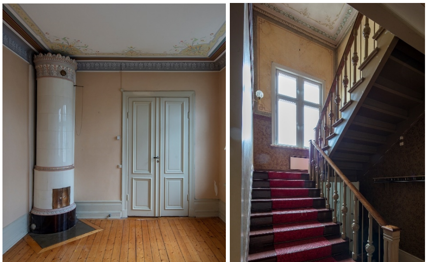
Bild 11 och 12. Kakelugn samt fyllningsdörrar till vänster, del av ursprungligt trapphus till höger. Bilder från västra flygeln.
