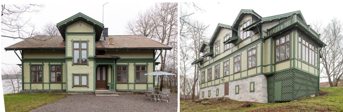
Bild 3, till vänster. Västra flygelns fasad mot söder. Byggnaden har ett utanpåliggande trapphus mot gårdsplanen med sidoställd farstuvist för huvudentré. Mot öster (till höger i bild) finns en svale med köksingång och mot väster (till vänster i bild) en veranda som vetter mot Långsjön. Taket har långa takutsprång. Takfoten är dekorativt utsmyckad med ursprungliga lövsågerier. Takfotens undersida är brädklädd och vilar på ursprungliga dekorativt utformade taksparrar.
