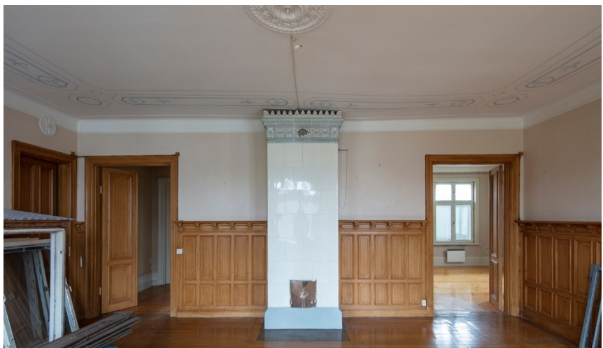
Bild 10. Salen, västra flygeln. I bilden syns en av kakelugnarna samt delar av den höga väggpanelen med ramverk och fyllningar (boasering).
