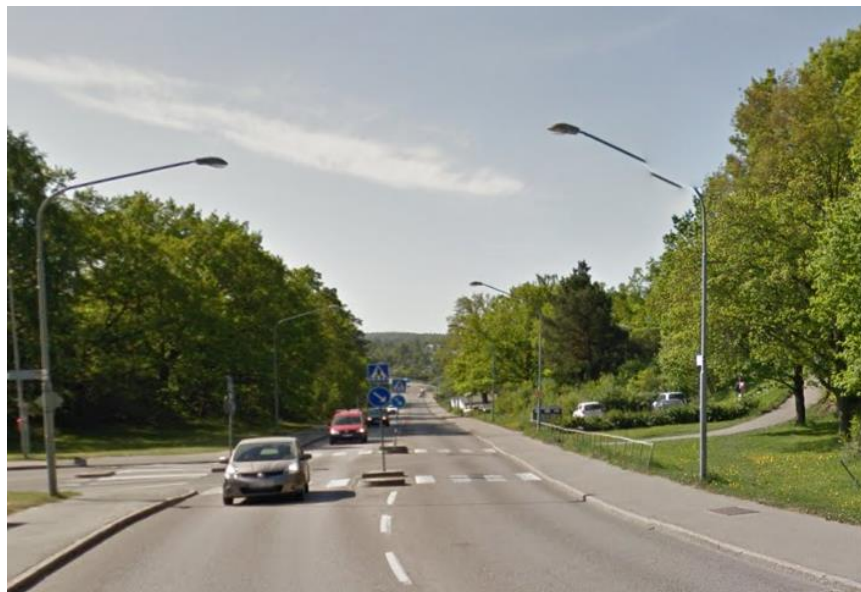
Vy över Bredängsvägen sedd från planområdet mot Bredängs trafikplats i söder.
