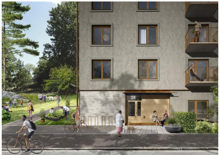
Sockelvåningen utförs i puts i samma kulör som fasad. Alternativt kan sockelvåningen helt eller delvis bekläs med tegel i kulör i likhet med fasad. Teglet muras på högkant. Entréparti utförs i ask eller ek samt med glas. Entrépartiet utförs något indraget och med skärmtak. Det kompletteras med identitetsbärande detaljer för Stockholmshusen såsom sittbänk, draghandtag och adresssiffra. Bild Dinell Johansson.
