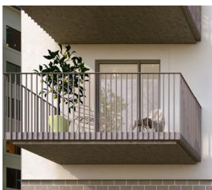
Balkong med pinnräcke. Den kan även utföras med perforerad korrugeradplåt. Balkongplattan i betong får en ursparning i framkant så att den upplevs nättare. Bild White.
