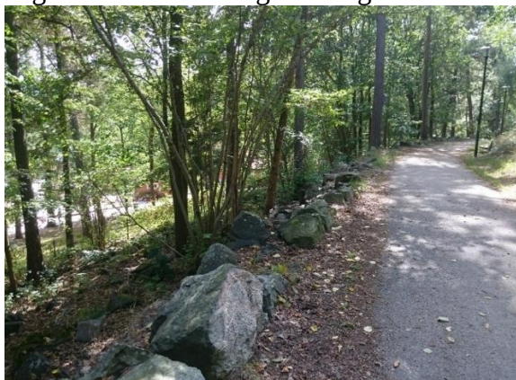
Foto på stenmur längs gångväg i sydslutningen inom planområdet. (Foto av Anna Ulfhielm, Almtunga AB)
