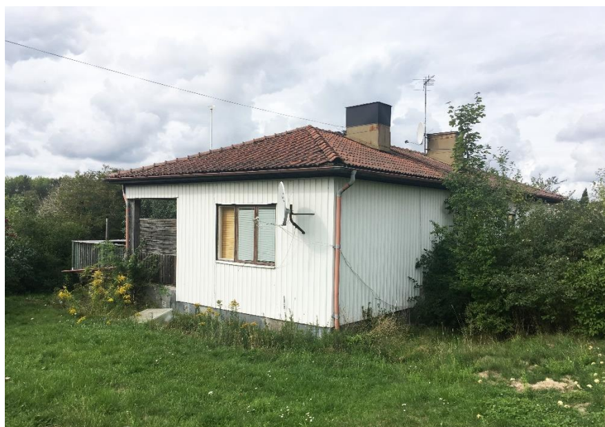
Befintlig byggnad som avses rivas.
