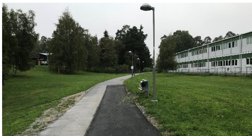
Gångstråk utmed Björnbodaskolan. Till höger syns del av skolgården och skolpaviljongen. Foto: Structor.
