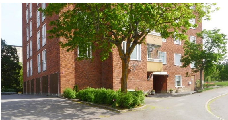
Punkthus på Medsolsbacken - bottenvåning med jämn indelning av öppningar för garage.
