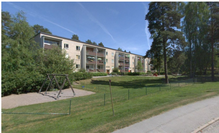
Befintlig byggnad inom planområdet sett från Fyrspannsgatan.
