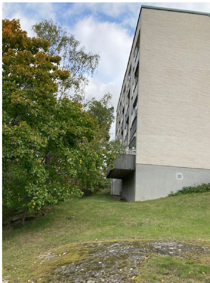
Hus D med betongsockel och kalksandstensfasad.
