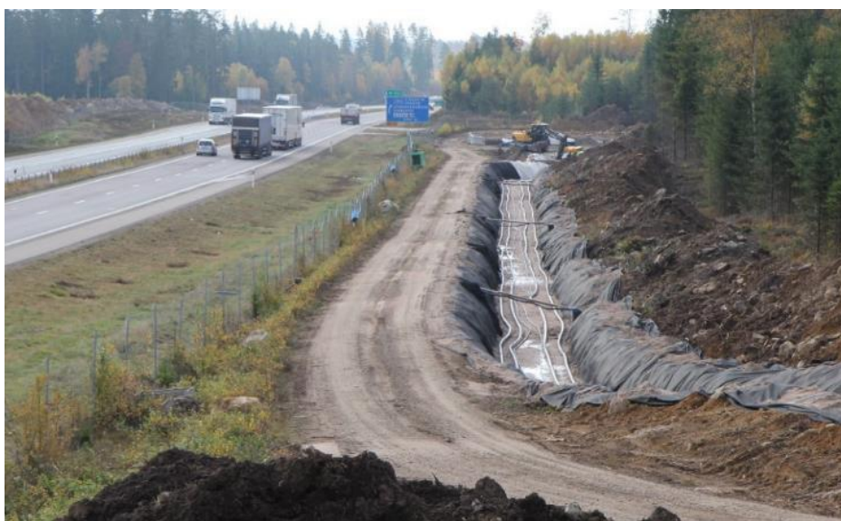
Figur 20. Exempel på markkabelschakt i tätortsnära miljö.
