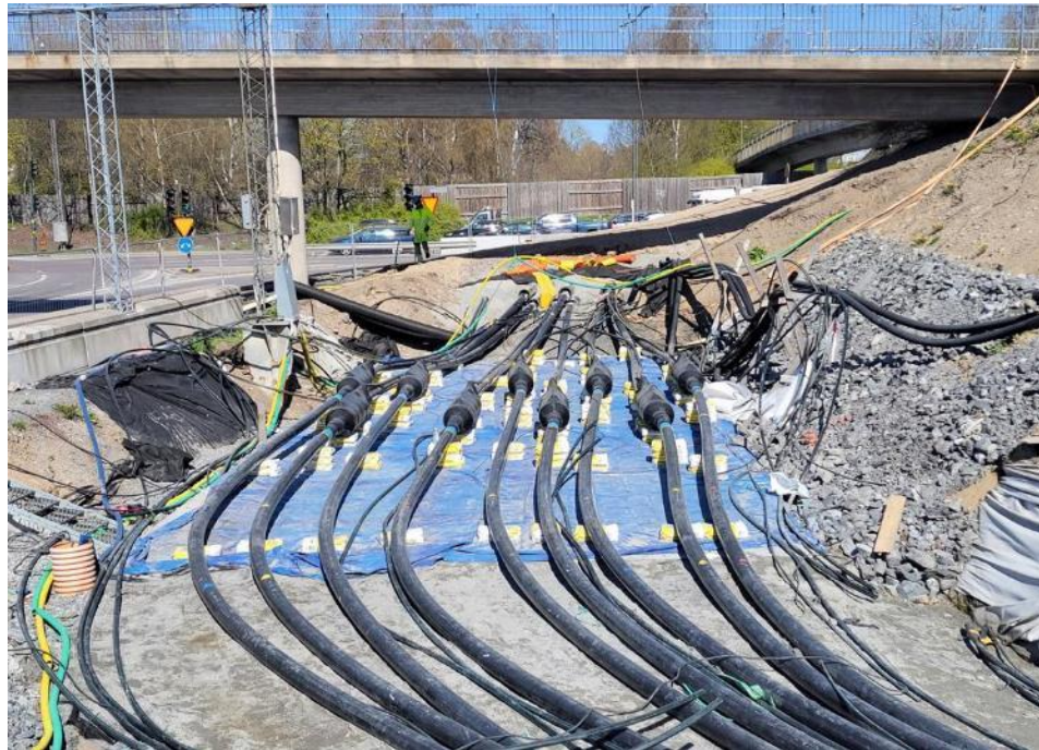
Figur 18. Exempel på hur en skarvplats kan se ut innan igenfyllning.
