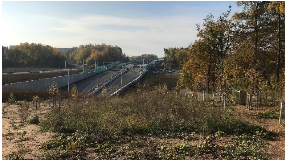
Figur 47. Planerad ledningsgata vid Hästa klack och Igelbäckens kulturresevat i anslutning till Förbifartens nyetablerade bro och betongtunnel med pågående återplantering.
