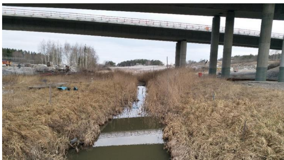
Figur 62. Bällstaån under nya vägbroar för Förbifarten vid Hjulsta trafikplats. Vy mot nordväst.
