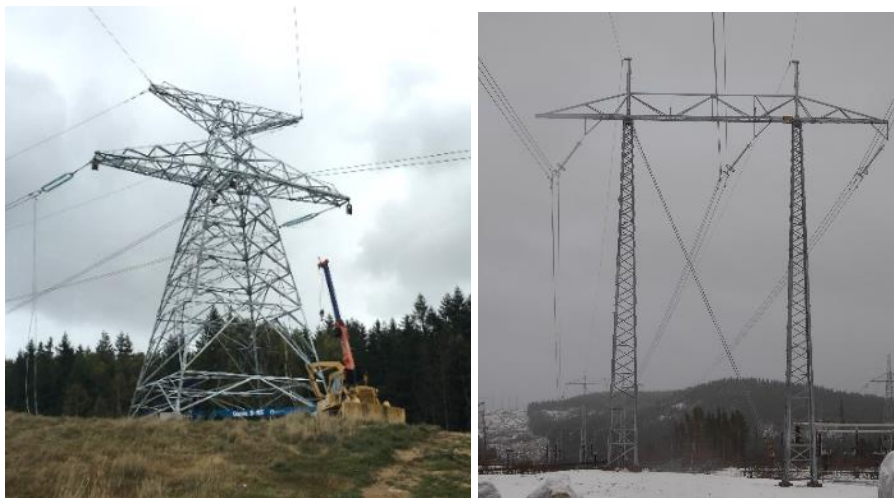
Figur 10. Exempel på vinkelstolpar. En stubbe till vänster och en vinkelstolpe (HV3) till höger.
