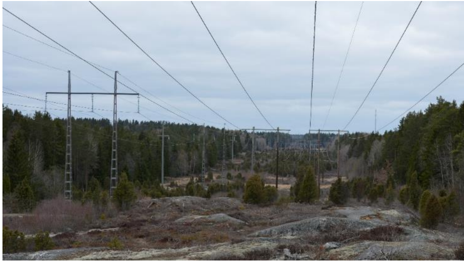
Figur 38. Befintlig och planerad ledningsgata i ett slutet landskap vid östra kanten av Östra Järvafältets naturreservat. Vy mot norr. Från vänster till höger ses Trafikverkets ledning med enkelstolpar, Svenska kraftnäts ledning med portalstolpar och Vattenfalls två ledningar med portalstolpar.
