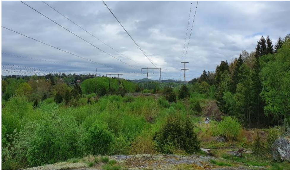
Figur 49. Utbyggnadsförslaget kommer att följa befintlig ledningsgata i kanten av Östra Järvafältet naturreservat till höger i bild. Fotot visar Trafikverkets ledning, Svenska kraftnäts 220 kV-ledning och Vattenfalls två ledningar, vy mot söder.
