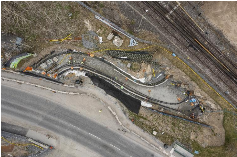
Figur 23. Schaktfri korsning av järnväg med hammarborrning.
