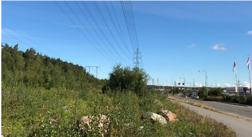
Figur 41. Utbyggnadsförslagets lokalisering vid befintlig ledningsgata mellan Hansta naturreservat och Norra Kolonnvägen. I området pågår entreprenadarbete för Förbifarten.
