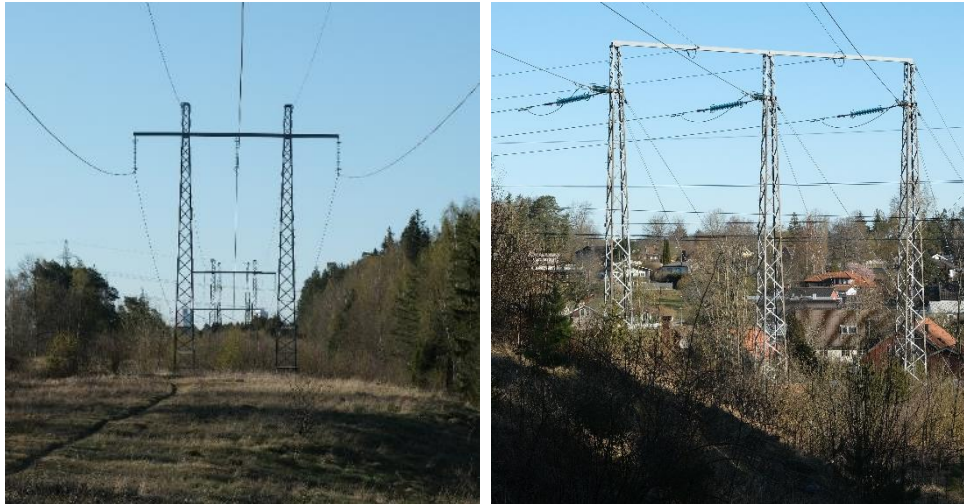
Figur 28. Foto på befintliga portalstolpar och vinkelstolpe i stål för KL22 S1-2 som ska rivras.
