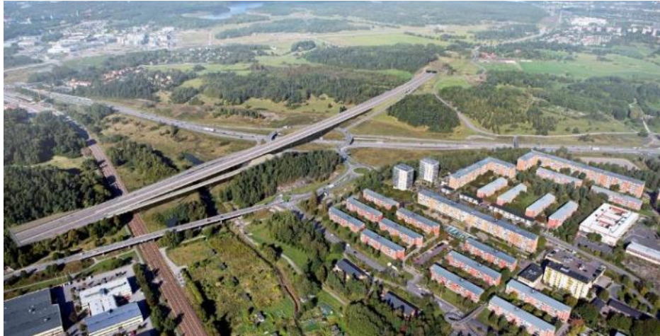
Figur 63. Översiktsbild av planerade Förbifart Stockholm vid Trafikplats Hjulsta och passage över Mälarnbanan samt nergången i betongtråg vid Hästa klack, vy mot norr. Foto: Trafikverket, 2015.
