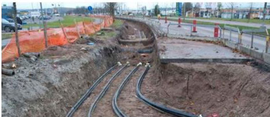
Figur 20. Exempel på markkabelschakt i tätortsnära miljö.
