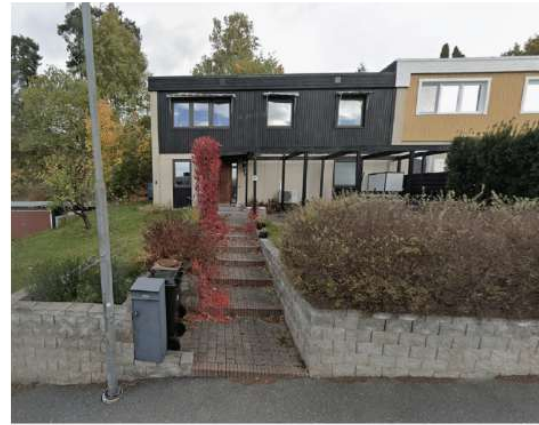
Mur och planteringar intill trottoar, Blomkronegränd
