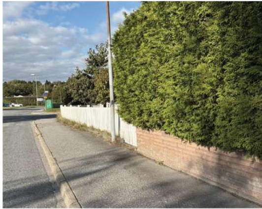
Staket, mur och häck mot Backlöksvägen
