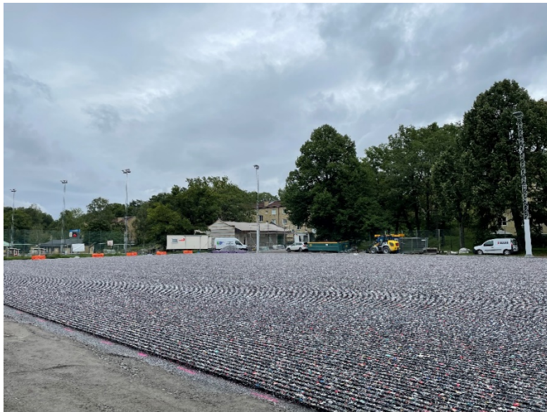
Ny sviktpad installerad, ett stötdämpande underlag som läggs under konstgräset.
