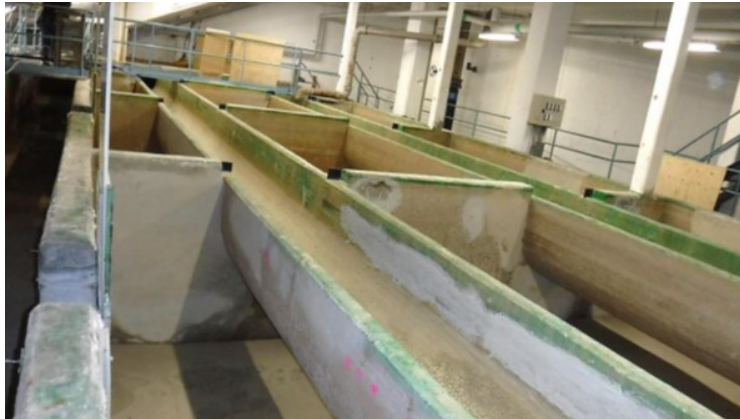
Sandfilterbassänger för rening av vatten innan renovering.
