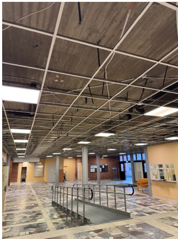
Undertaksplattor nedtagna för säkerställande av projektering rördragning.
