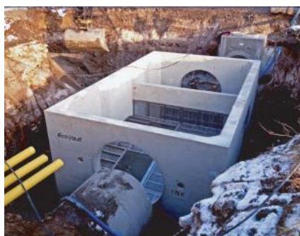
Figur 8. Exempel på tekniska underjordiska reningsenheter som skulle kunna rena dagvatten inom Lilla Värtans tillrinningsområde, där det råder stor platsbrist 26 .
