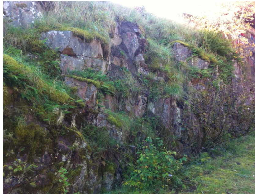
Figur 12 (höger): Bergskärningen närmast bron lämnas utan åtgärd. Uppkommande björk tas bort om slänten buskar igen. Bärande buskar lämnas. Gräs nedan berget slås med samma metod som slänterna.
