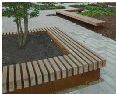
En stor del av marken i kvarteret kommer ligga på bjälklag. Planteringarna blir upphöjda för att växterna ska få tillräckligt
