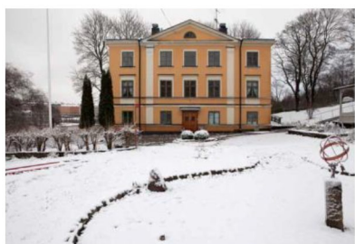
Befintlig huvudbyggnad från väst.
