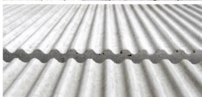
Fasad utförd i betong eller sten.
