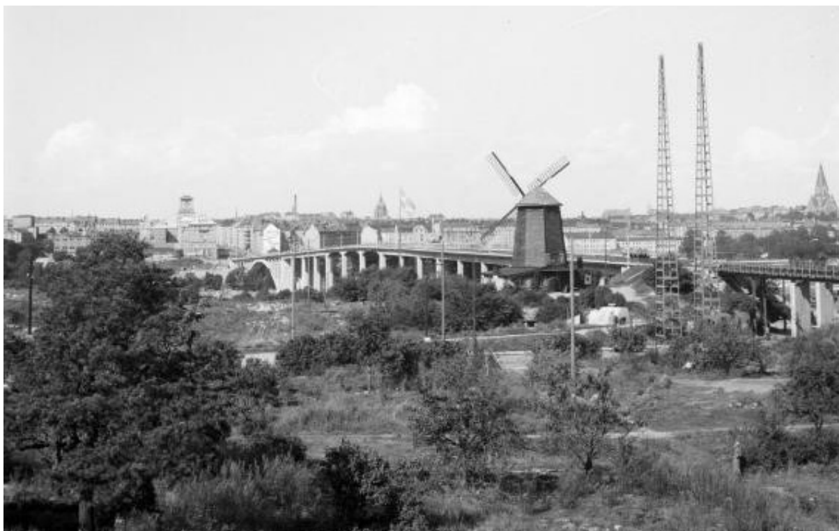
Figur 53. Skanstullsbron och Skanskvarnen från söder. Foto: Stockholmskällan
