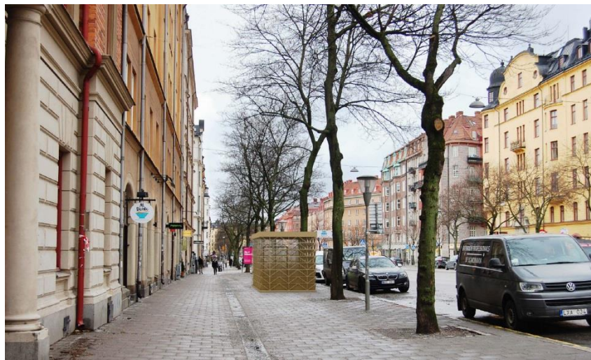
Fotomontage som visar placering av byggnad för utrymning Karlbergsvägen mellan Sigtunagatan och Hälsningegatan
