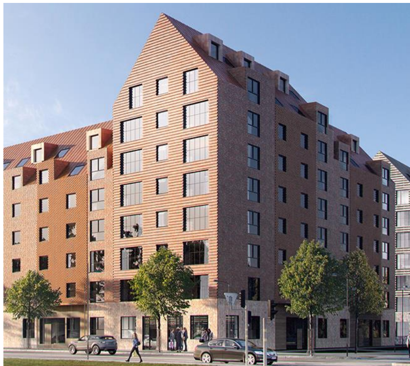
Vy från Örbyleden och Grycksbovägen som visar byggnadens indelning av fasad samt sockelvåning (Källa: Sandellsandberg).
