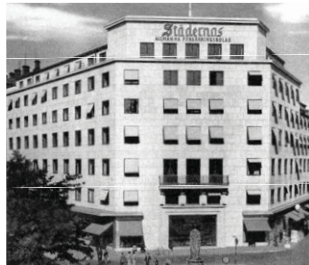
BYGGNADEN RITADES AV ARKITEKT GUSTAF CLASON DY
