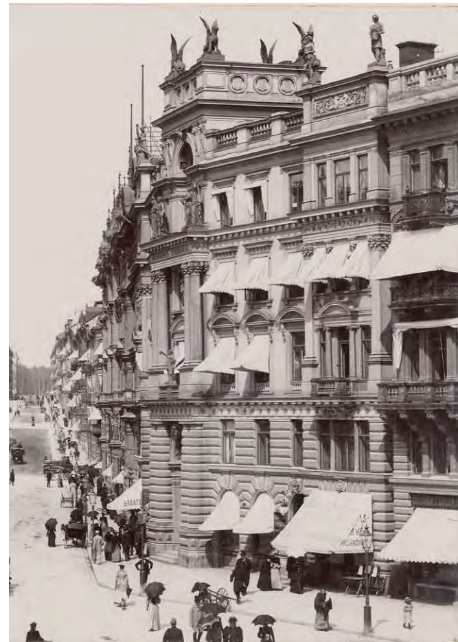
BÅNGSKA PALATSET I SIN URSPRUNGLIGA PRAKT. SSM
