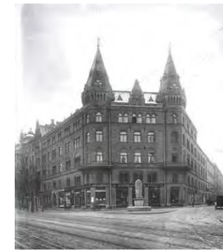
FASTIGHETEN I KVARTERETS SÖDRA DEL REVS PÅ 1930-TALET FÖR ATT GE PLATS ÅT STÄDERNAS ALLMÄNNA BRANDTODSBOLAG. SSM
