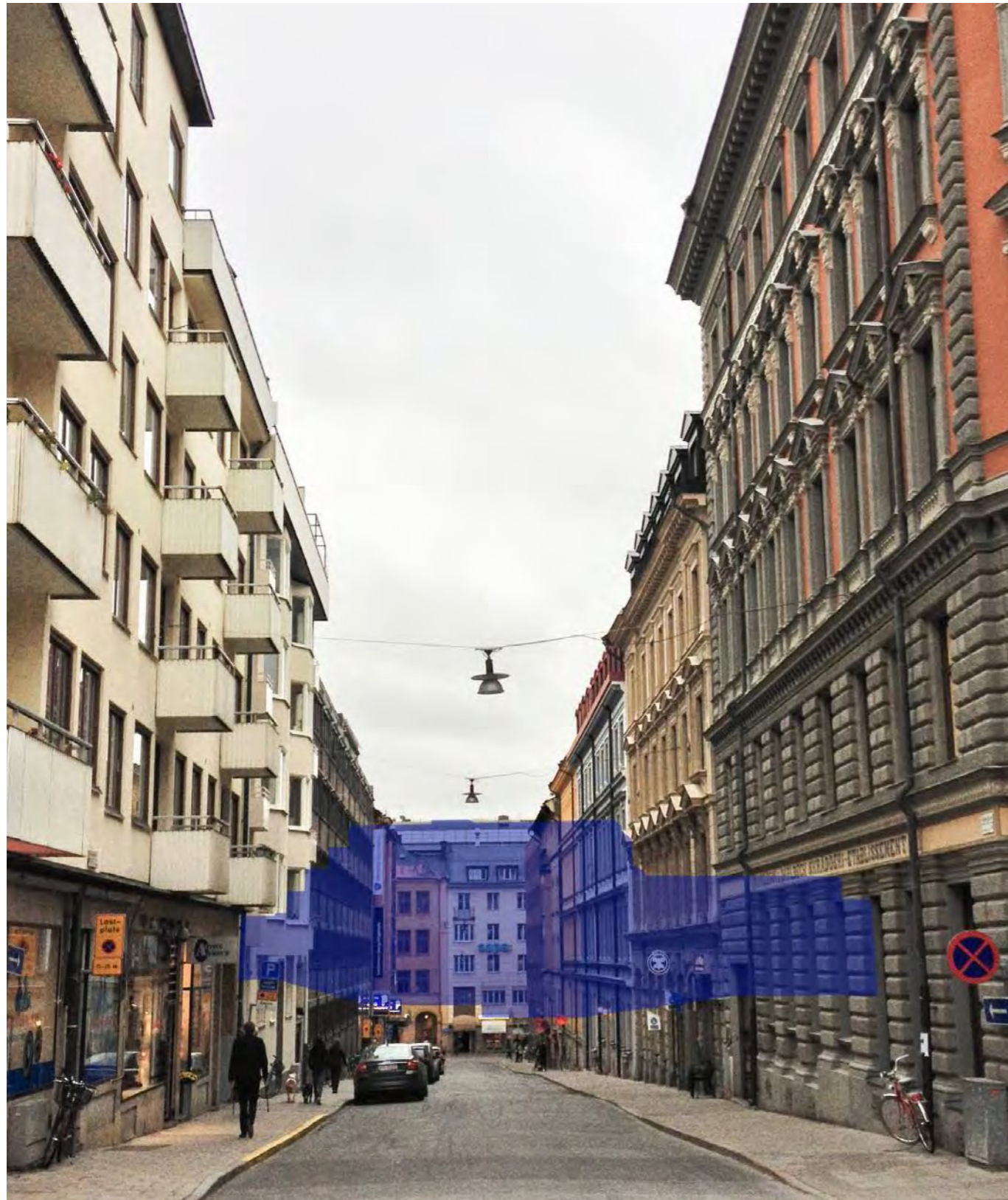
Den samlade volymen av påbyggnadsmöjligheter enligt gällande detaljplan är markerad i blått.
