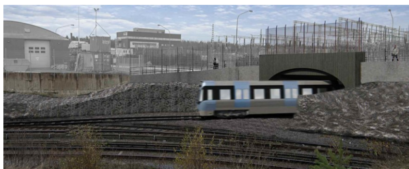
Anslutningsspår till befintlig Högdalsdepå. Aktuell vy visar det norra spårets tunnelmynning vid Kvicksundsvägen.
