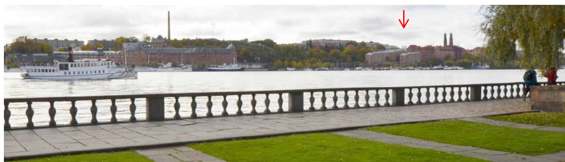
Vy från stadshusparken. En av de planerade byggnaderna tecknas mot himlen ovanför bostadshuset vid Münchenbacken. Ytterstadens bebyggelse tar därmed plats i Södermalms siluett. Byggnaden framträder dock på ett diskret sätt och påverkar inte Högalidskyrkans betydelse.
