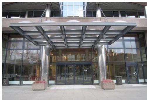
Pelare klädda i rostfri plåt Entréparti med skärmtak mot Årstaängsvägen
