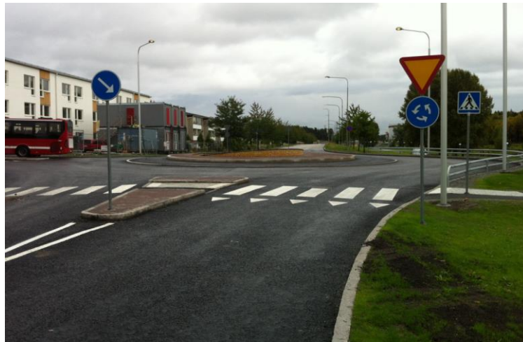
Bild 6: Cirkulationsplats med ej överkörningsbar rondell
