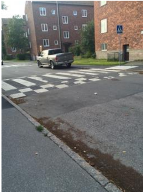
Bild 2: Upphöjt övergångsställe (platågupp)
