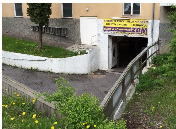
Befintlig garagedfart till verksamhetslokal.
