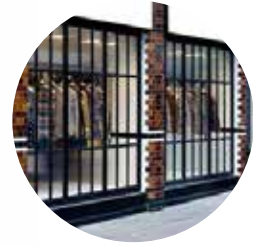
Stora spröjsade glaspartier med industriell karaktär
