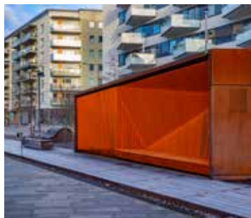
En teknikbyggnad som bidrar med flera kvaliteter till det offentliga rummet genom sin skulpturala utformning och integrerade sittplatser i fasaden. Norra Djurgårdsstaden.
