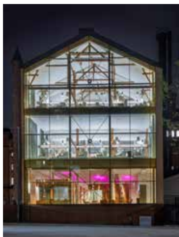
En helt öppen fasad som exponerar insidan av ett kontorshus och bidrar till att levandegöra gaturummet både dag- och kvällstid. Kungsholmen.
