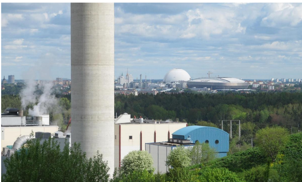
Figur 38. Utblick norrut över Högdalenverket mot centrala Stockholm.
