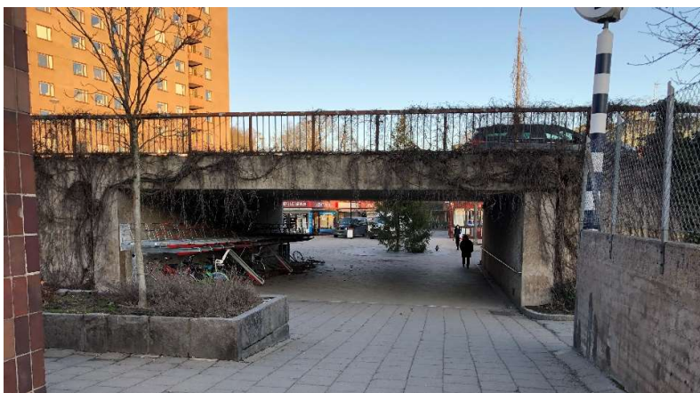
Passage mellan Axelsbergs torg och Hägerstens torg genom gångtunnel under Selmedalsvägen
