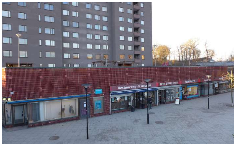
Fastigheten Förgyllda bågaren 8 (Bild AIX)
