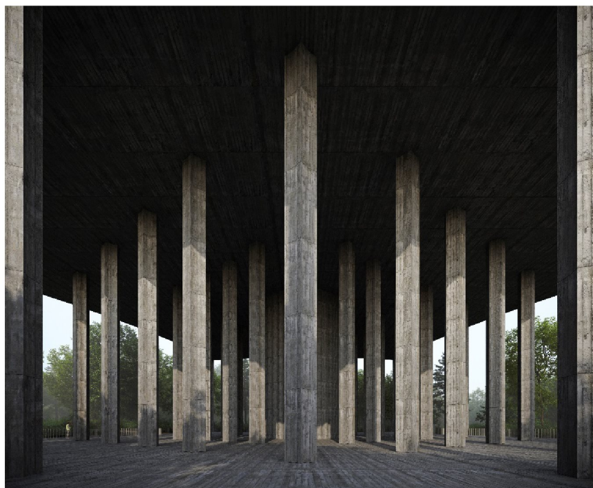
Vattencisternen vilar på ett mittorn omgärdat av en pelarsal med 60 stycken pelare med en minsta frihöjd om 14 meter.
