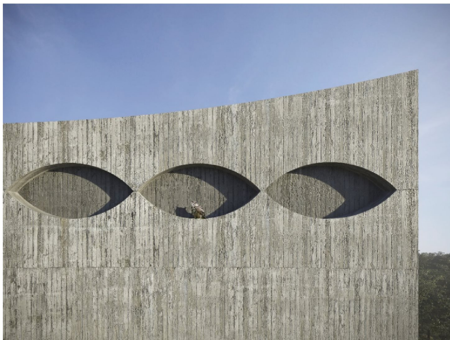
Den nya vattenreservoaren gestaltas med längsgående lansettformat mönster i djup relief. En av dessa håligheter kan med fördel förberedas som en häckningsplats.
