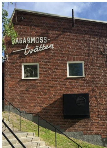
Referens. Tvätteribyggnad. Tegelfasad och pulpettak.
