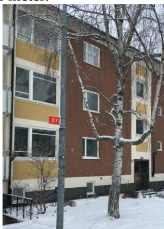
Befintligt lamellhus vid Bergsrådsvägen.
