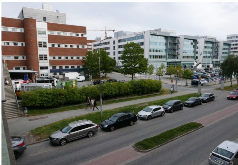
Hus 2 med nuvarande parkering till vänster i bild sett från Kistagången (bron över Isaffordsgatan).
