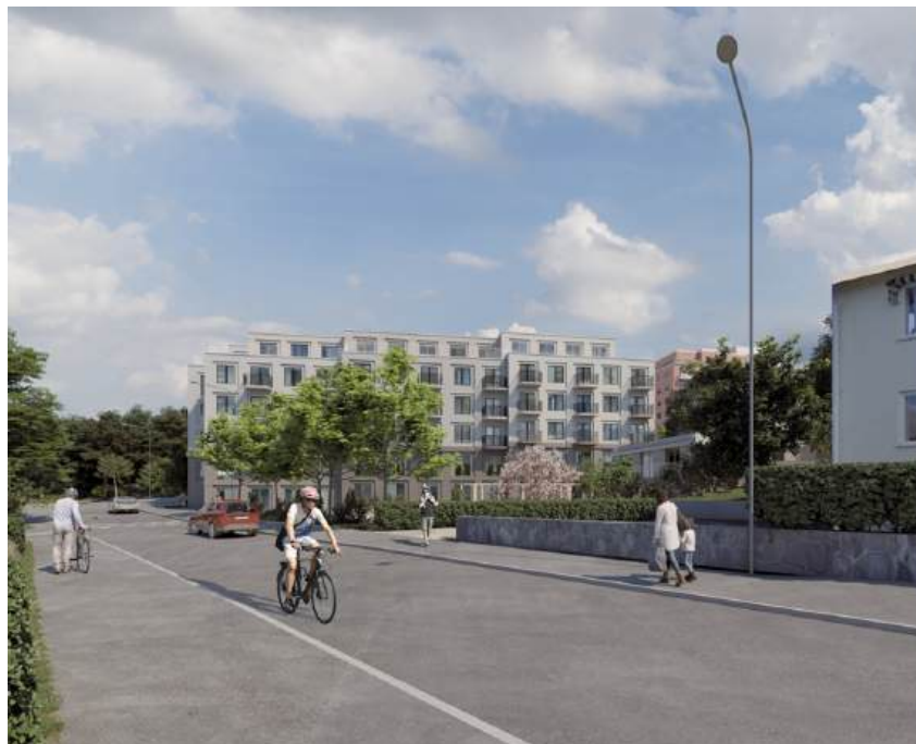
Visualisering av flerbostadshuset på södra sidan av Bällstavägen Källa: Tengbom.
