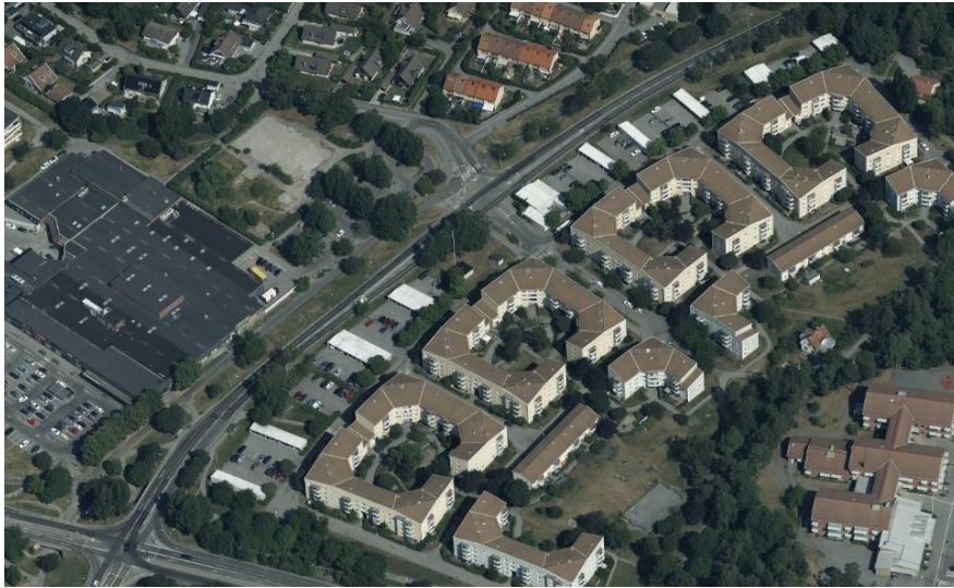
Markparkering i anslutning till Växthusvägen.
