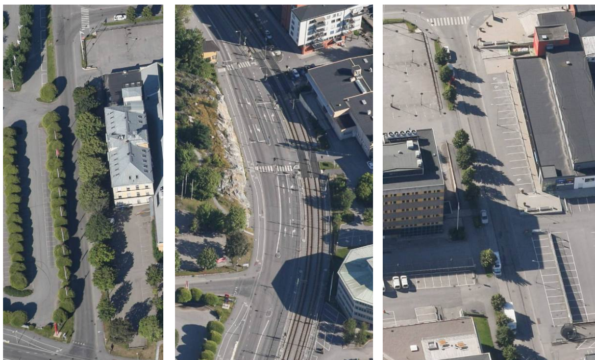
Karaktären på befintliga gator. Gårdsfogdevägen till vänster, Karlsbodavägen i mitten och Archimedesvägen till höger.
