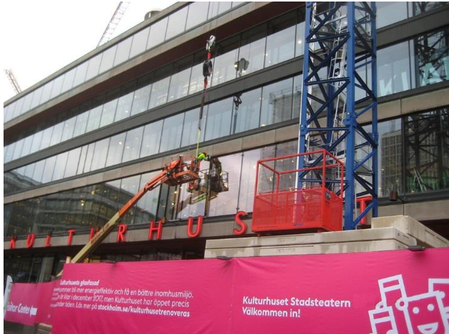
Byte av fasadglas, Kulturhuset, Sergels torg
