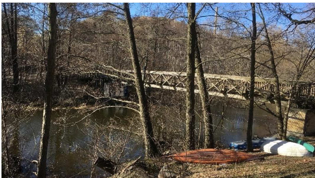
Figur 15. Befintlig gång- och cykelbro över Sicklasjön.
