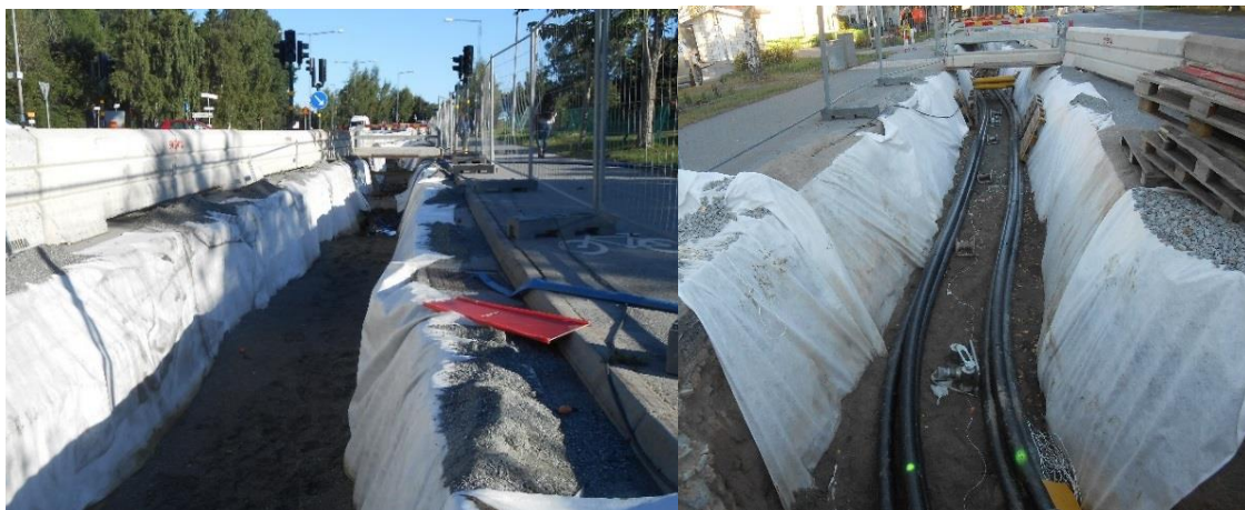
Figur 5. Exempel på markkabelschakt i stadsmiljö.
