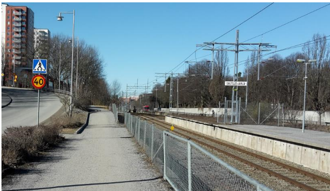
Figur 26. Ledningssträckning i gång- och cykelbana innan passage under järnvägen vid station Saltsjö-Järla,
