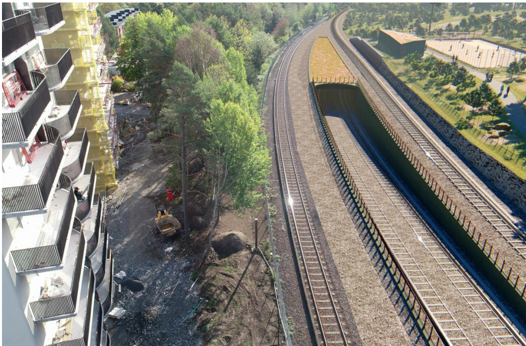
Figur 19. Tunnelmynning och tråg vid anslutning till Farstagrenen.
