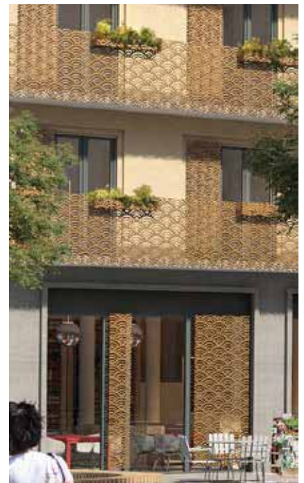
Sockelvåning och balkongräcken.
