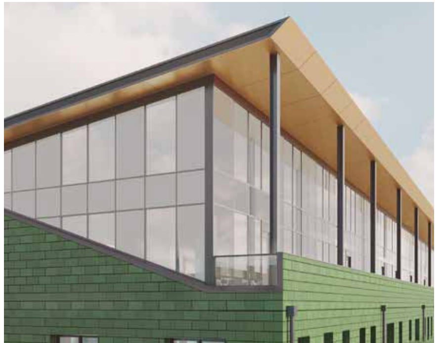
Takvåning och takform.
