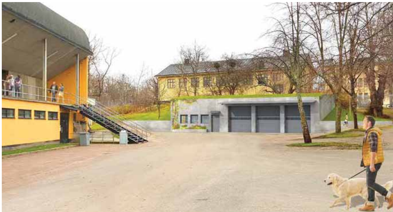
Vy mot förrådet med läktarens baksida till vänster.
