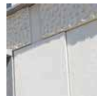
Bearbetad och slät betong
