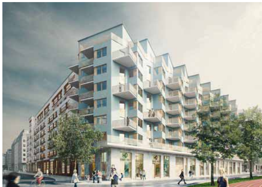
Vy i hörnet Nordenflychtsvägen och Elersvägen.
