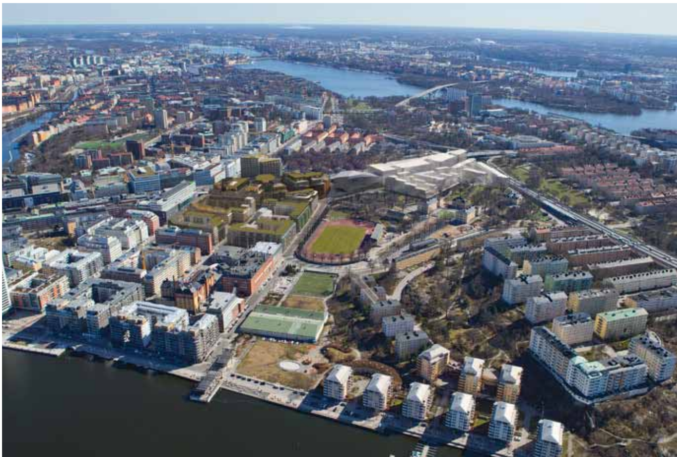
Vy över området med planerad bebyggelse inom Hornsbergskvarteren. Planerad bebyggelse söder om planområdet visas också i bilden med vita volymer för att visa områdets helhet. Bild: ÅWL Arkitekter.
