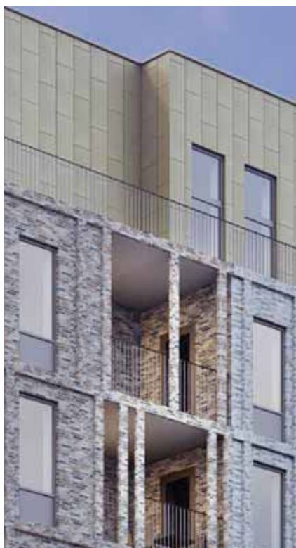
Indragen takvåning och balkonger.
