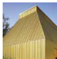
Guldfärgad plåt på tak
