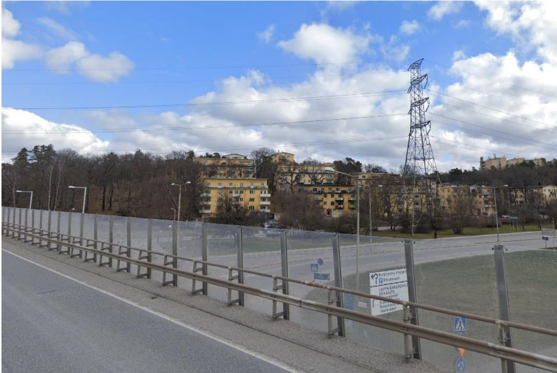
Figur 11. Stolpe nr 544 vid Bergiusvägen och bostadsområdet Ekhagen. Stolpen kommer ersättas av två kabeländstolpar närmare Norrtäljevägen. Foto Google Maps.
