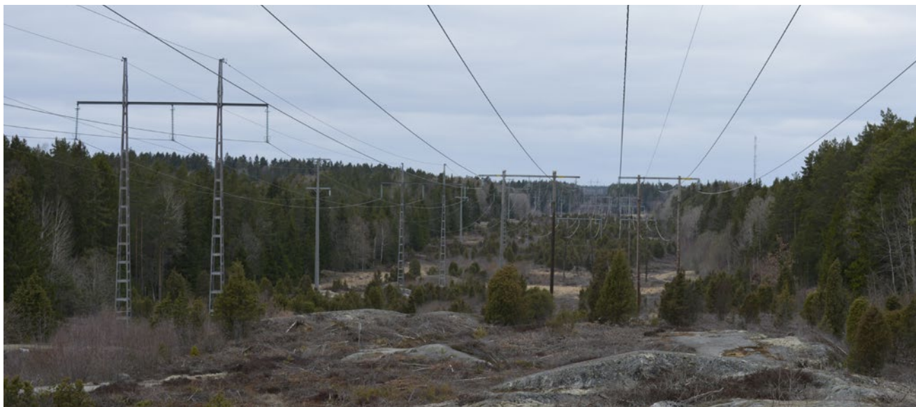
Figur 21. Befintlig ledningsgata i ett slutet landskap vid Viby. Från vänster till höger visar fotot Trafikverkets enkelstolpe, Svenska kraftnäts portalstolpe och Vattenfalls två portalstolpar. Vy mot norr i riktning mot station Överby.
