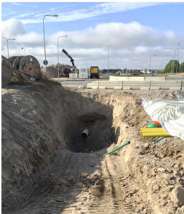
Figur 19. Bergborrning av markkabel.
