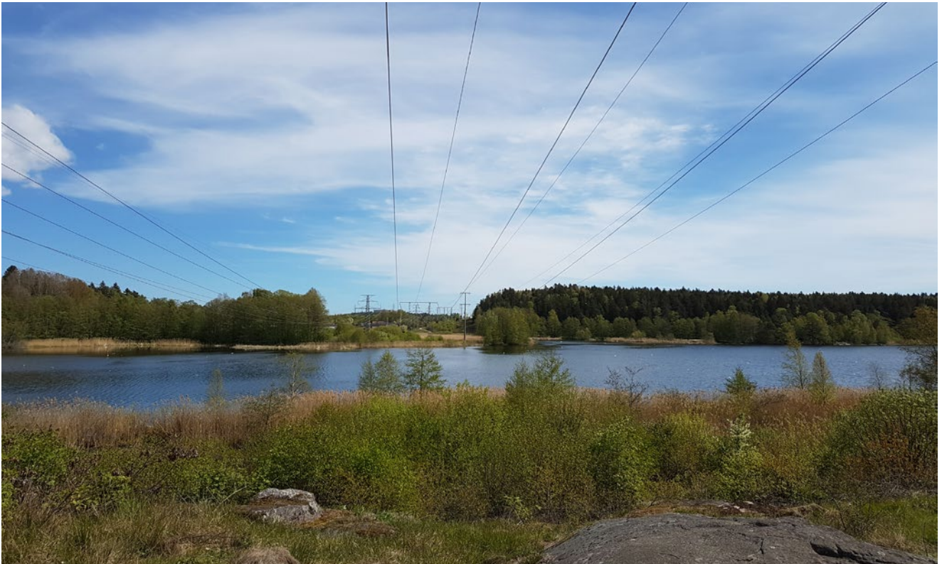
Figur 23. Befintlig kraftledningsgata över sjön Ravalen vid Pommern. Vy mot öster.
