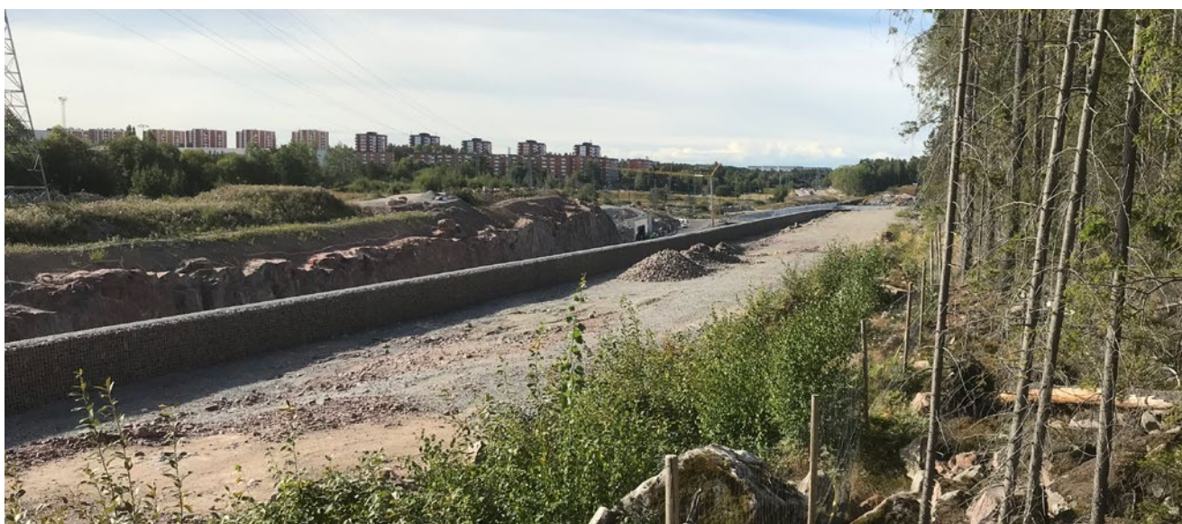
Figur 25. Vy mot Akalla vid pågående bygg- och vägarbeten av Förbifart Stockholm i kanten av Hansta naturreservat. Markkabel planeras i kanten av reservatsgränsen.
