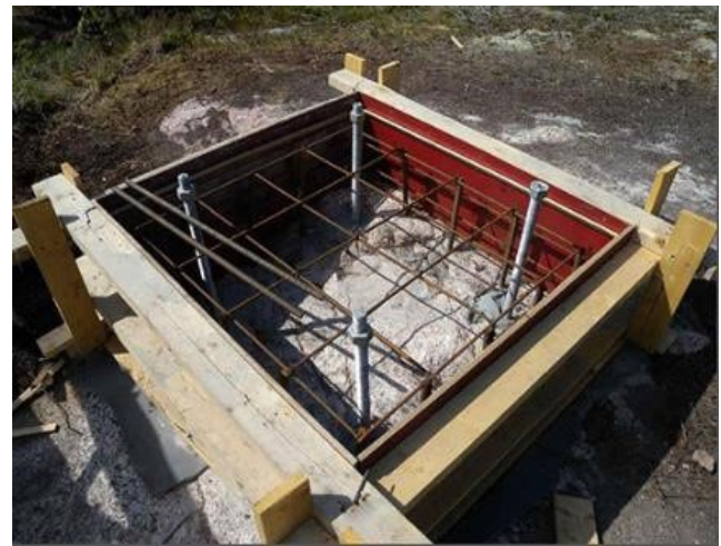
Figur 11. Foton som utvisar olika fundamentstyper, till vänster ett jordfundament med stålbeak och stålslipers och till höger ett bergfundament.
