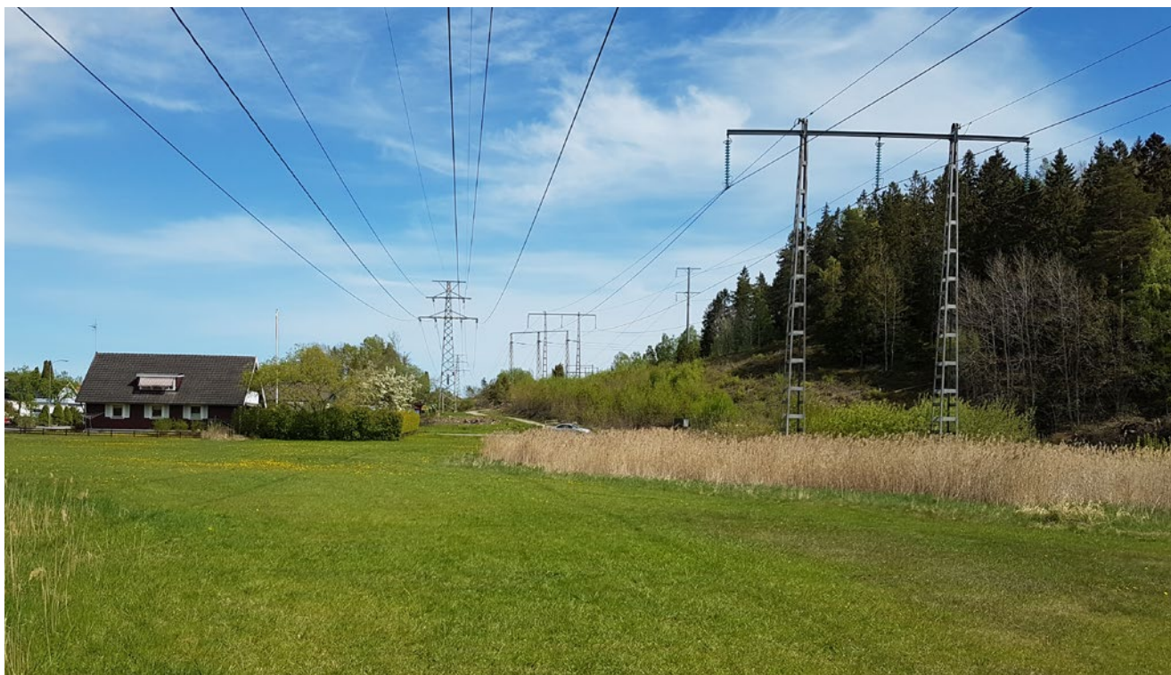
Figur 29. Befintlig kraftledningsgata vid Pommern med närliggande bostäder och den skogsklädda höjdryggen som den planerade luftledningen lokaliserats till. Vy mot öster. Foto: Sweco
