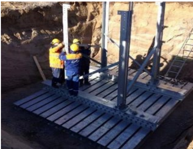
Figur 11. Foton som utvisar olika fundamentstyper, till vänster ett jordfundament med stålbeak och stålslipers och till höger ett bergfundament.
