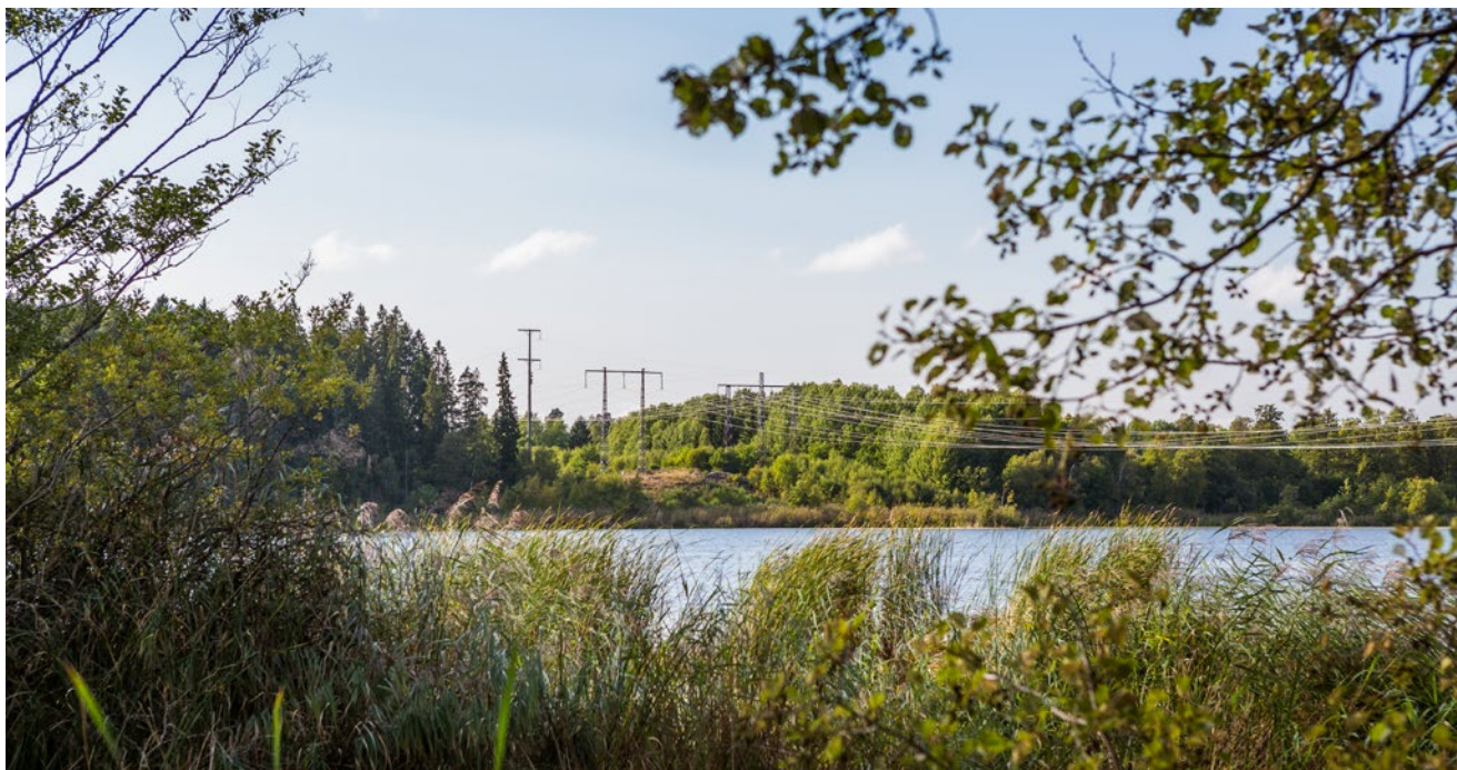
Figur 39. Befintliga ledningar vid passage av sjön Ravalen.
