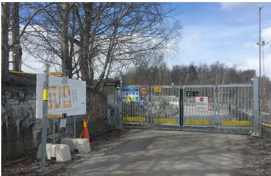
Bild 2 Automatiska grindar i Norra Djurgårdsstaden
