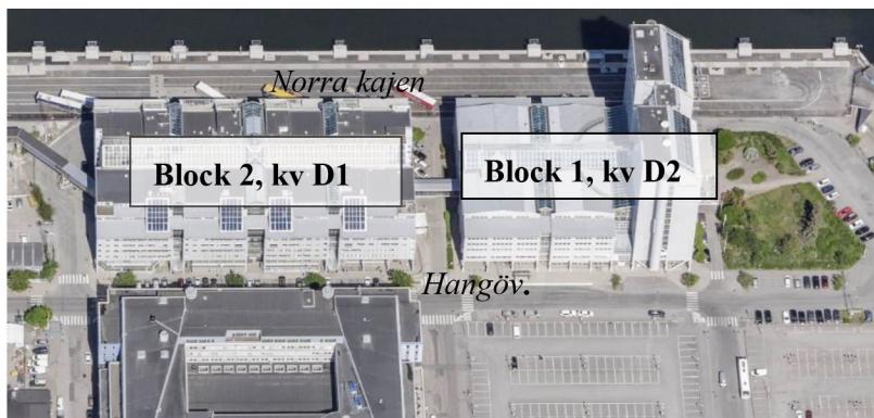
Flygbild mot norr som visar befintlig byggnad inom fastigheten Neapel 3 samt dess två olika delar, block 1 och block 2.
