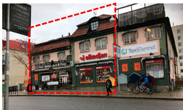
Spånga järn- och färghandels fasad mot Värsta allé. Den ursprungliga delen av byggnaden som ska bevaras är markerad i rött.
