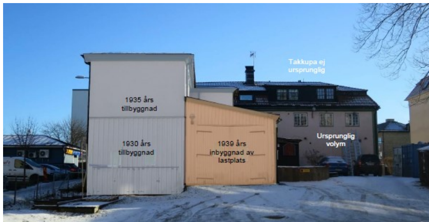
Spånga järn- och färghandels fasad mot nordväst.
