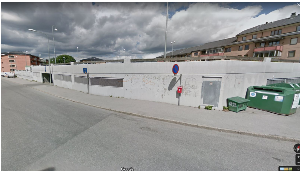
Bild 5. Gatuvy från Åstorpsringen befintlig situation.
